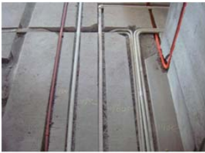
(1) 水管区域的砂浆修补
