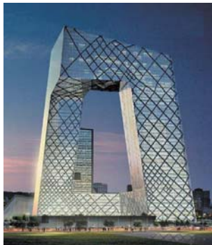
北京CCTV Beijing CCTV
