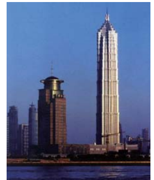
上海金茂大厦 Shanghai Jinmao Tower
