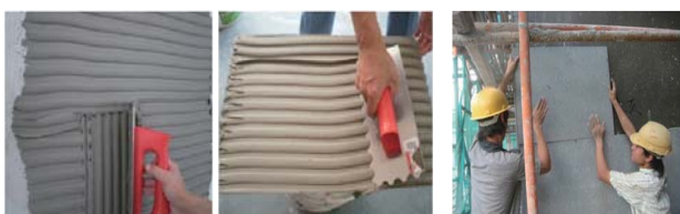
(1) 基层刮胶，石材背面刮胶
